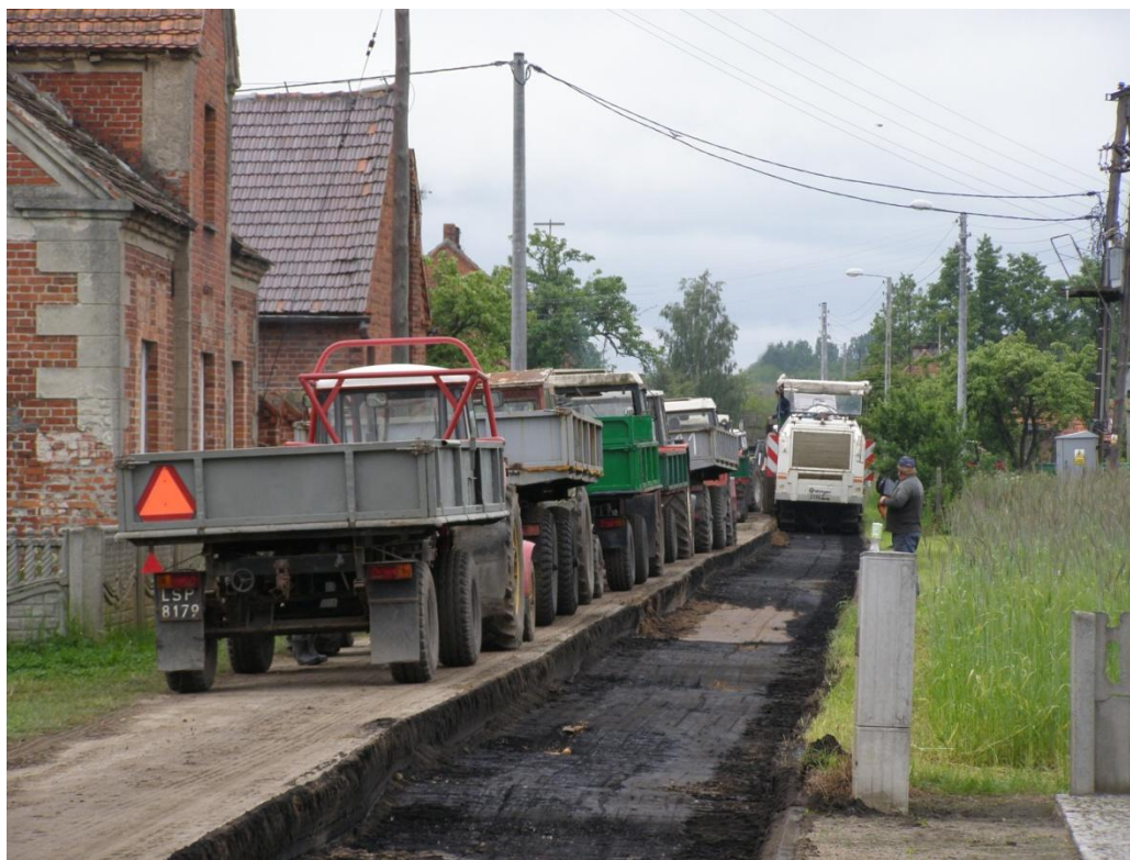
Budowa drogi w Bielawach
